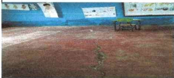
Foto 2. Sustitución de piso
