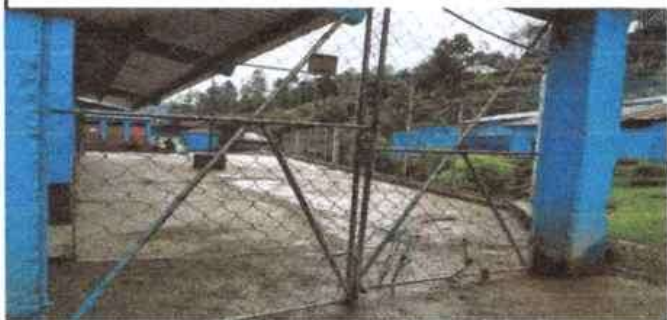
Foto 1. Sustitución de portón de metal
