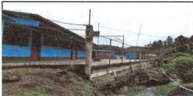
Foto 3: Sustitución de Perímetro de Circulación
